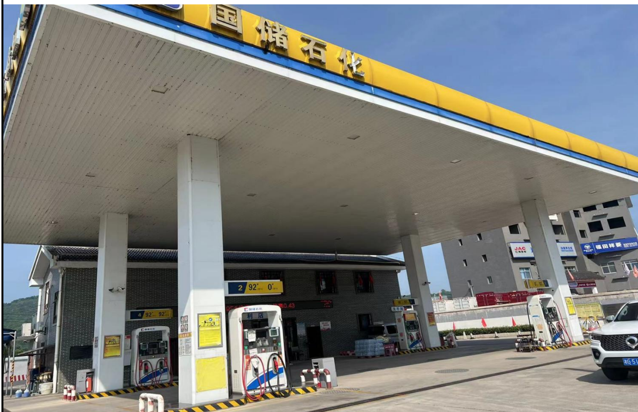
项目检测现场照片
