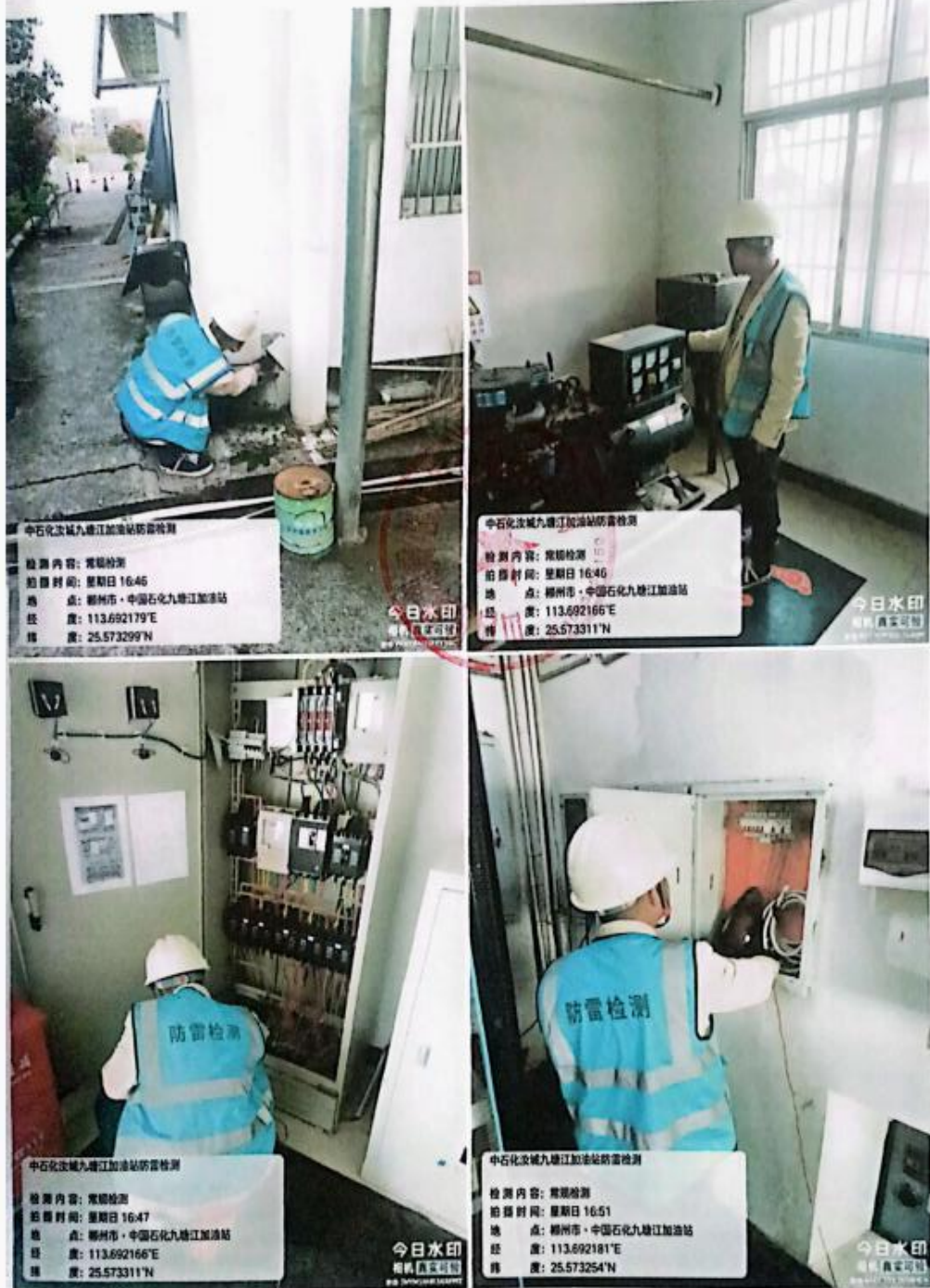
现场检测照片
